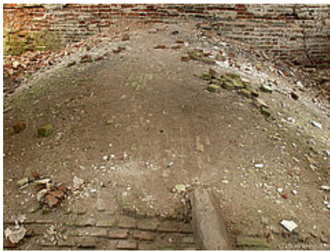
Так выглядят со второго этажа кирпичные потолки первого этажа
