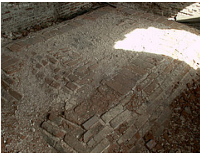
Так выглядят со второго этажа кирпичные потолки первого этажа
