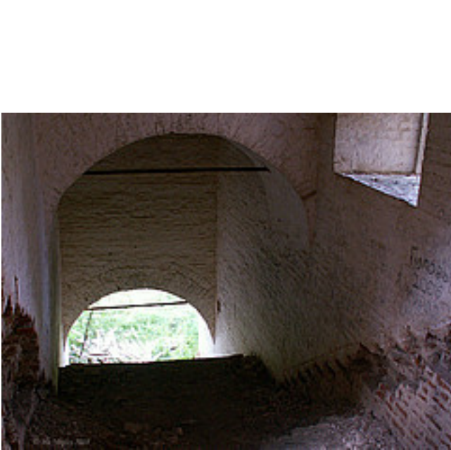
Так выглядят со второго этажа кирпичные потолки первого этажа
